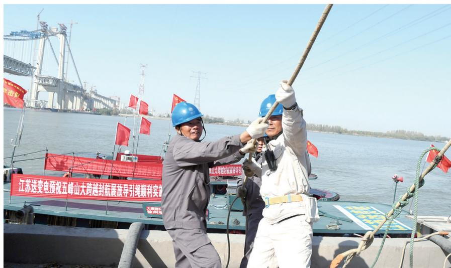
14日,施工人员在镇江220千伏五峰山大跨越改造施工现场开展架线作业。据悉,线路按照220千伏双回路架设,本期架线计划施工周期为13天,施工期间共展放OPGW光缆2根、特强钢芯铝合金导线6根共计12根。自2018年6月,五峰山大跨越改造工程历经旧线拆除、旧塔爆破、新塔基础施工组塔等阶段,工程架线施工完成后,输电能力较原来提升3倍以上,能够更好的满足电力南北传输需求。
