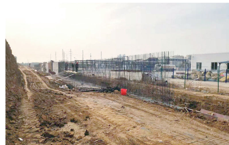
江化微项目配套道路建设。王维青 摄
