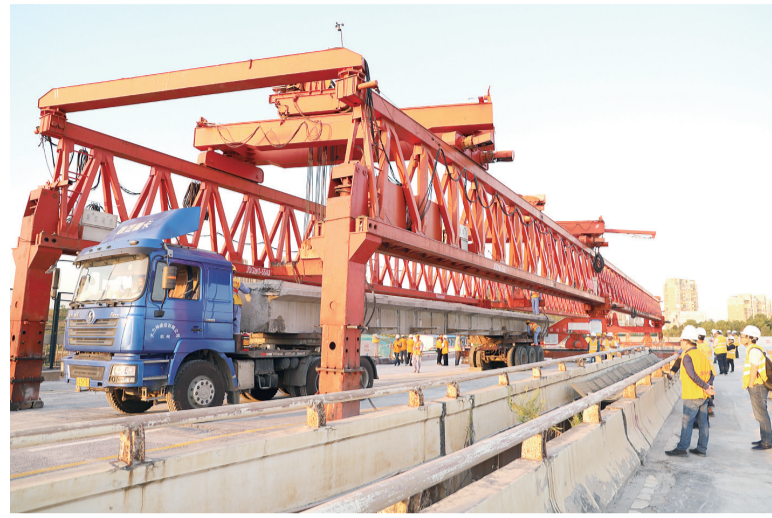
桥梁被放上货车。方良龙 摄 镇扬铁路镇江联络线,桥梁两端与谷阳路顺接。工程于6月初封闭施工,7月30日开始拆除老桥防撞护栏、栏杆和人行道等附属设施。计划2020年12月底完工,2021年春节前通车。(方良龙 杜广展)
