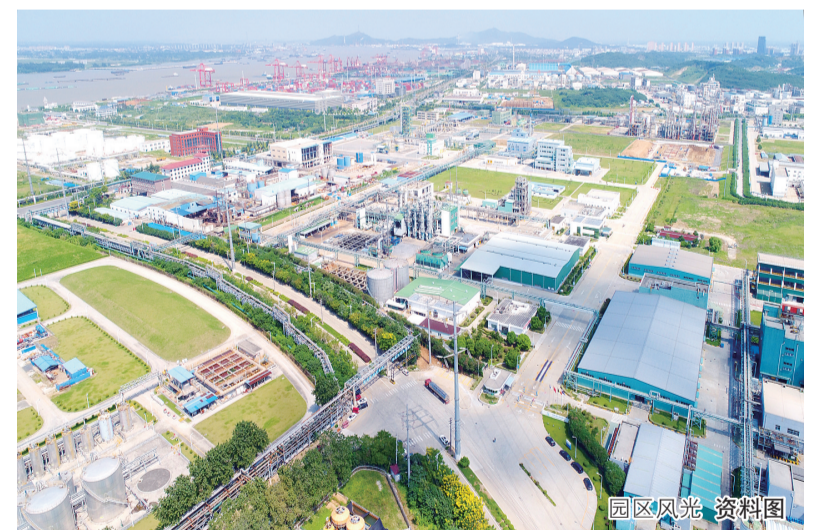
园区风光 资料图 展大会播响了加快打造绿色生态安全的现代化化工产业体系,推进高质量产业强区的号角。有了“党建+安环”的融合管理方式,园区党委将进一步有效带动36个非公企业党支部,集聚起最大公约数,推动园区一盘棋共赴高质量发展征程。顾宗侠 龚江婷 金敏
