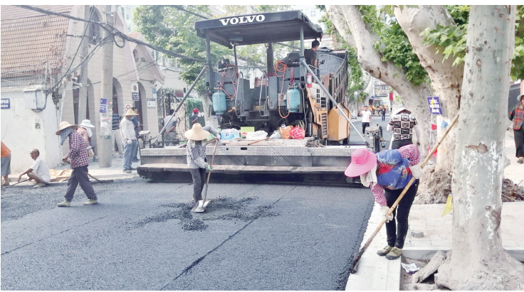
图为仁章路沥青摊铺作业 方良龙 摄
