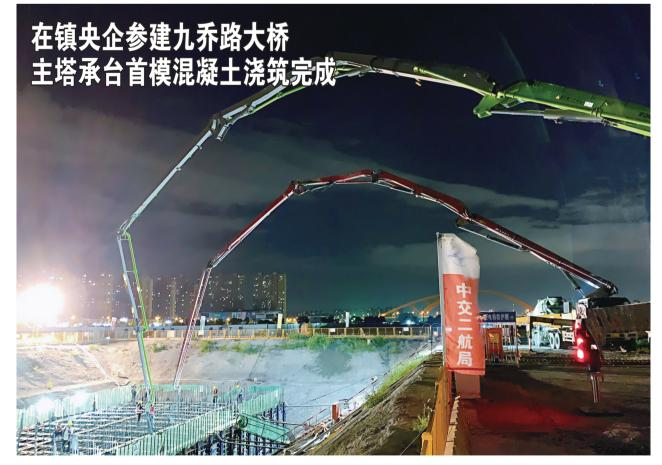
8月25日晚,在镇央企中交二航局参建的京杭运河整治工程杭州段八堡船闸项目九乔路大桥主塔承台首模混凝土完成浇筑。据了解,该项目为国家重点工程京杭运河浙江段三级航道整治工程杭州段关键节点工程,建成后,千吨级船舶可以从山东直达杭州,通过八堡船闸进入钱塘江,"船等闸"现象也将成为历史。 杨贺 黄鑫 谢道韫 摄影报道
