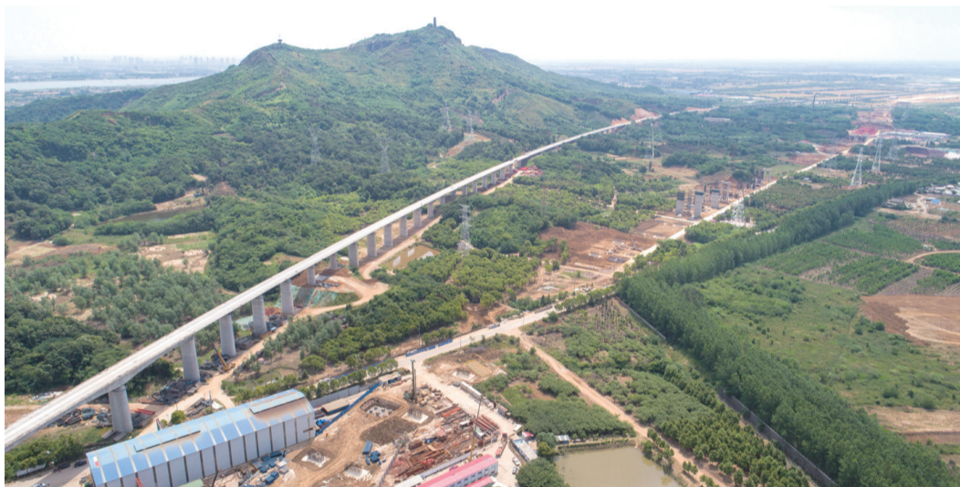
24日，镇江五峰山过江通道南北公路接线工程正在进行杆管线路施工。谢道轹 摄
