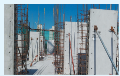
楼面施工中搭起的剪力墙 方良龙 摄
