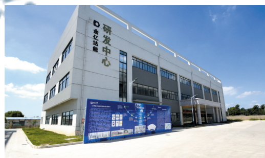
金亿达能移动终端设备生产等34个项目开工建设。
