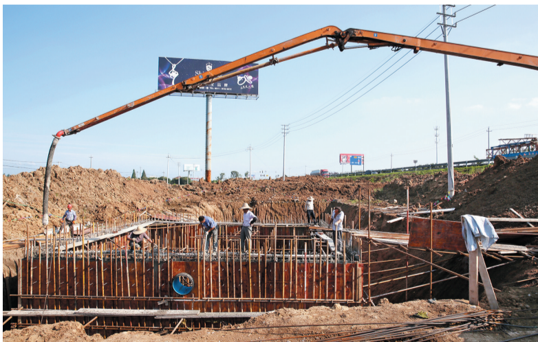
张庙村污水管网建设。
