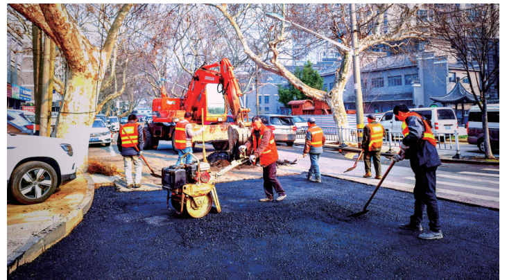
3月8日,江苏镇江中华路,工作人员正在摊铺沥青,对受损的路面进行修复,方便市民出行。
