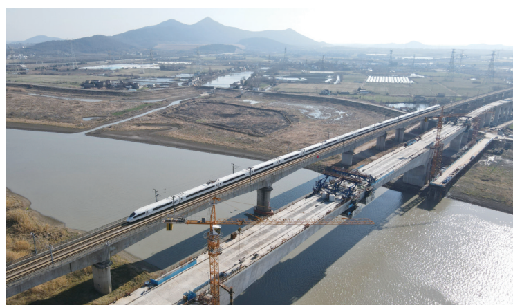
宁马城际铁路姑溪河特大桥合龙
