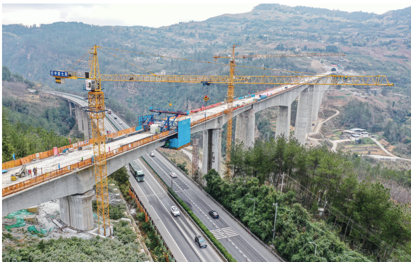
这是1月15日拍摄的石梁河双线特大桥施工现场(无人机照片)。
