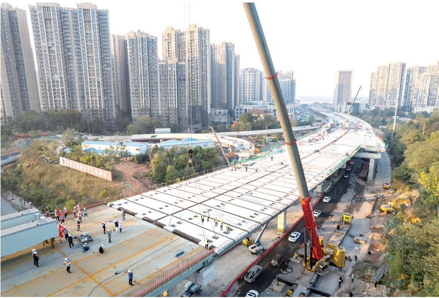
12月4日，由中铁五局承建的长沙市重点民生工程万家丽路快速化改造北延线工程主体完工。工程建成后，将缓解长沙城东的南北向交通拥堵和现有万家丽北路交通饱和问题，缩短长沙县进入长沙主城区的行车时间。图为施工现场。 新华社发
