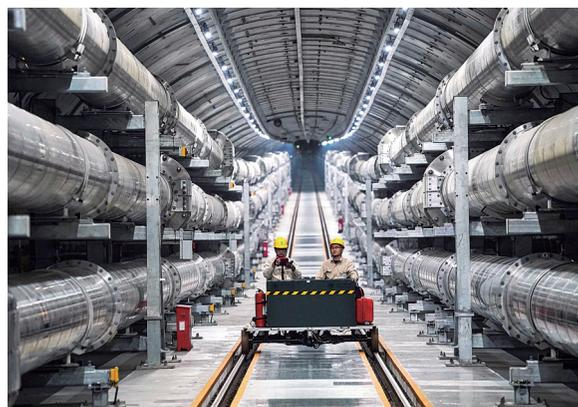
近日,华东特高压交流环网过江的关键节点——苏通 GIL 管廊跨江送电超 1000 亿千瓦时。苏通 GIL 管廊工程起于长江南岸苏州,止于北岸南通,于 2019 年 9 月正式投运。该工程采用“紧凑型特高压 GIL+大直径长距离水下隧道”穿越长江,江底“埋线”长达 5.5 公里,总投资 47.63 亿元。
