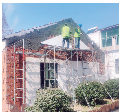
施工人员应用超高韧性混凝土对危旧房山墙进行加固 受访者供图
