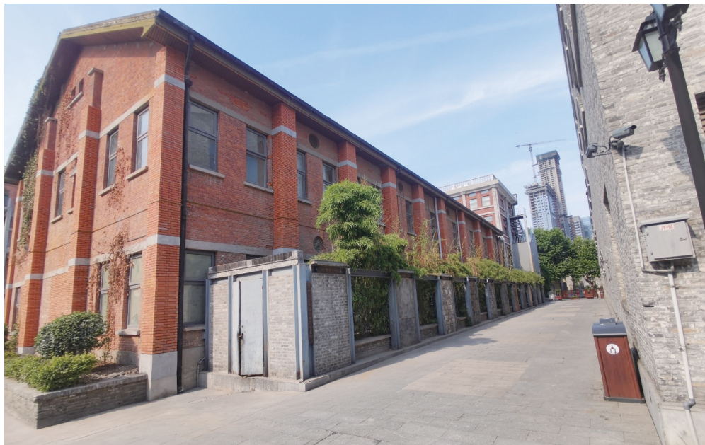
雅狮酒店3号楼抗震加固工程
