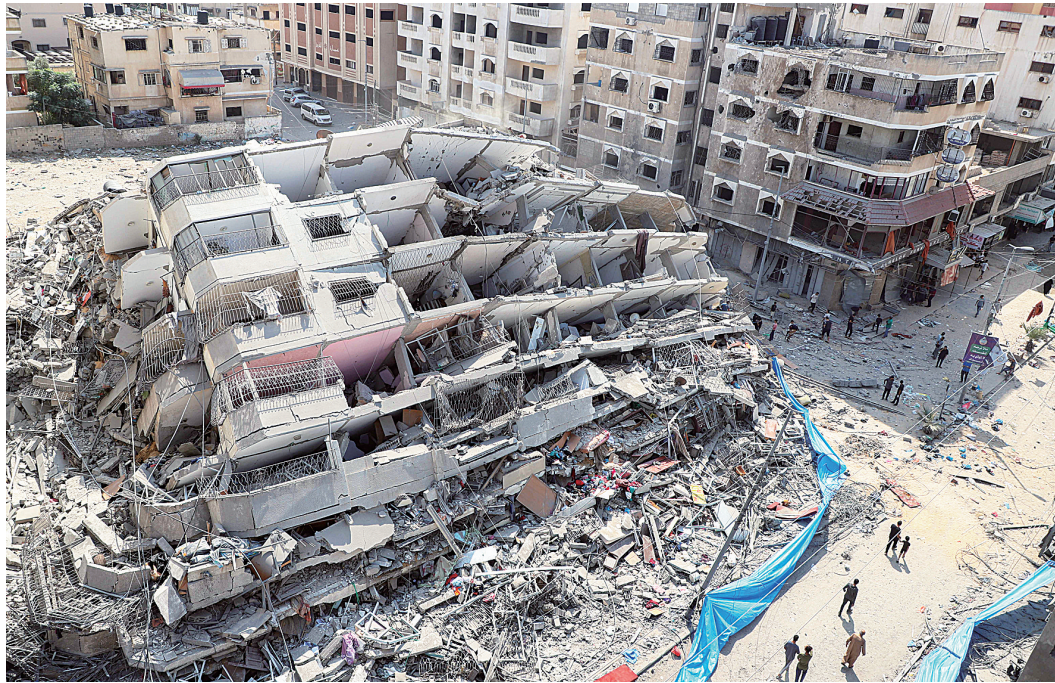
这是10月8日在加沙城拍摄的以色列空袭后的建筑废墟。 新华社发
