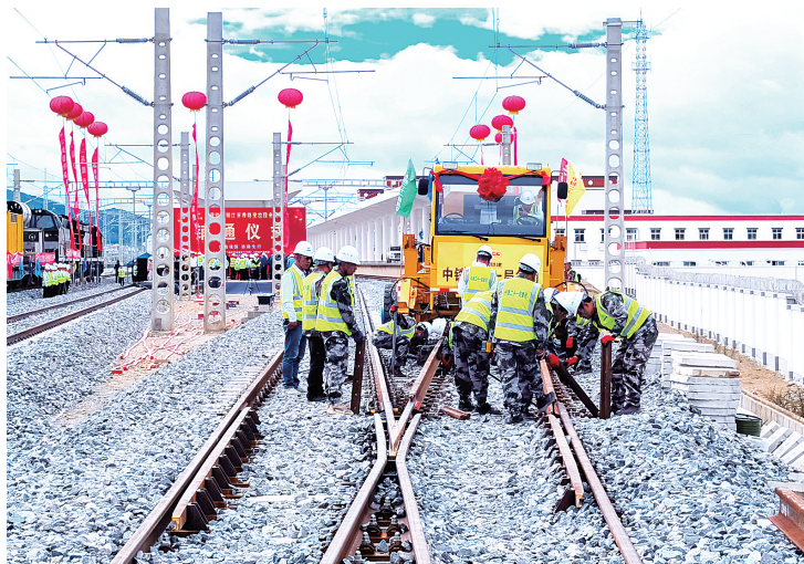
9月19日,在云南省迪庆藏族自治州香格里拉站施工现场,随着最后一对500米长钢轨精准落在道床上,滇藏铁路丽江至香格里拉段全线铺轨完成,为年内开通运营奠定坚实基础。丽香段开通运营后,迪庆藏族自治州将结束不通铁路的历史。图为施工人员在滇藏铁路丽香段香格里拉站铺轨。
