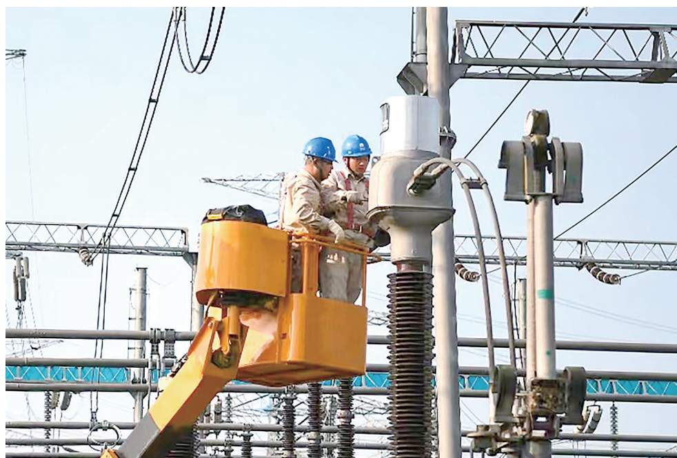
9月9日,国网镇江供电公司员工在位于丹阳市陵口镇的220千伏南凤变电站对220千伏母联电流互感器开展变比调整作业。近期,当地乡镇企业快速发展,用电负荷持续升高,供电公司及时调整、提升电流互感器变比。
