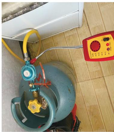
更换具有自闭功能的减压阀后检测是否泄漏
