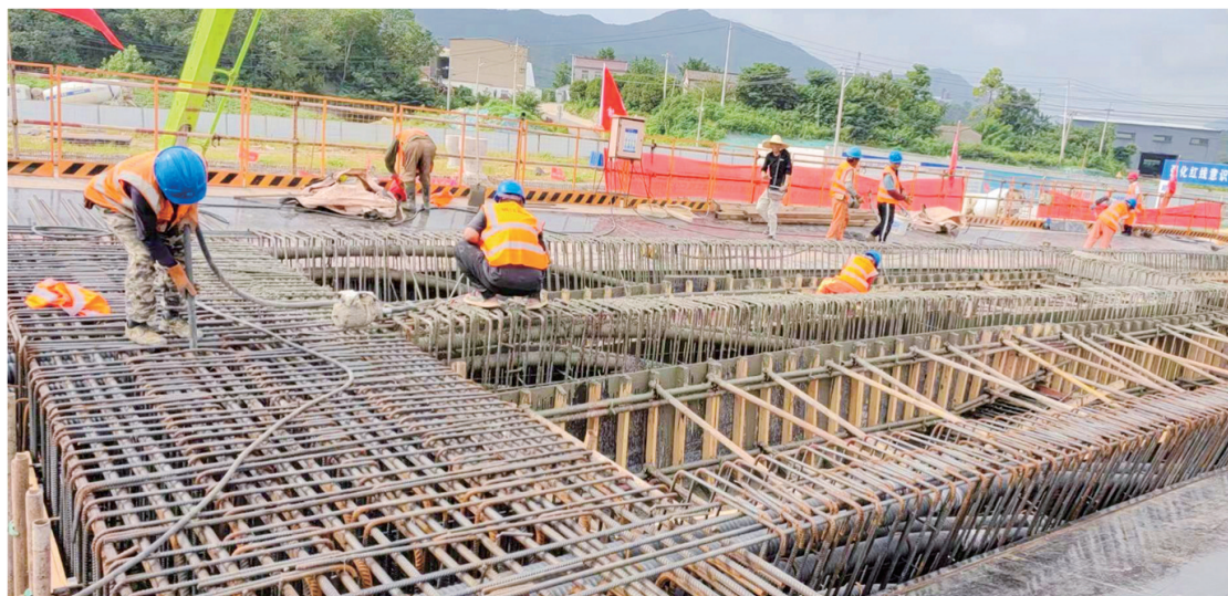
9月5日,312国道346国道宁镇段改扩建工程CQ2标互通F匝道桥首联现浇箱梁底腹板全部浇筑完成,标志着312国道互通正式进入上部结构施工阶段。 陆晓霖 黄帅 摄影报道
