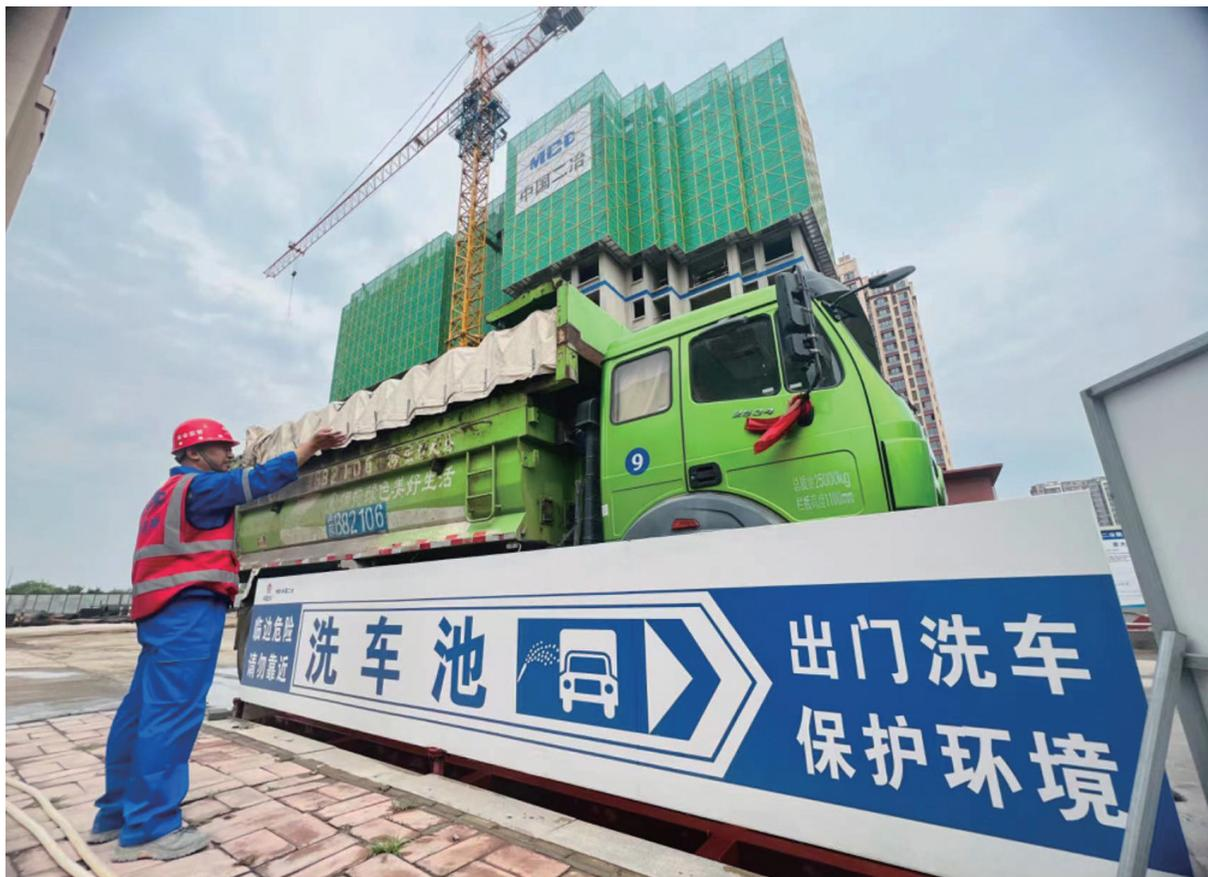
日前,中国二冶内蒙古包头市米兰春天房地产项目,工作人员指挥施工车辆通过出口处的汽车清洗装置。绿色环保、文明节能的理念,贯穿施工全过程。
