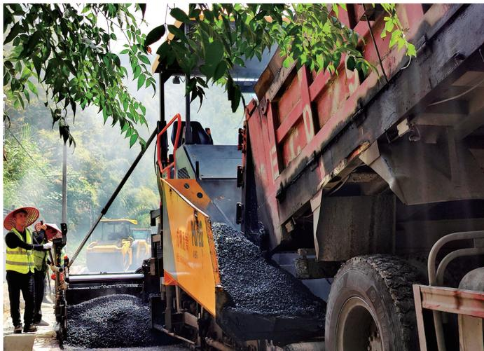
8月20日,养护人员头顶烈日,忙着对浙江开化县道公路城白线视坑吸二桥的桥头伸缩缝进行修复,打造安全畅通的交通环境。
