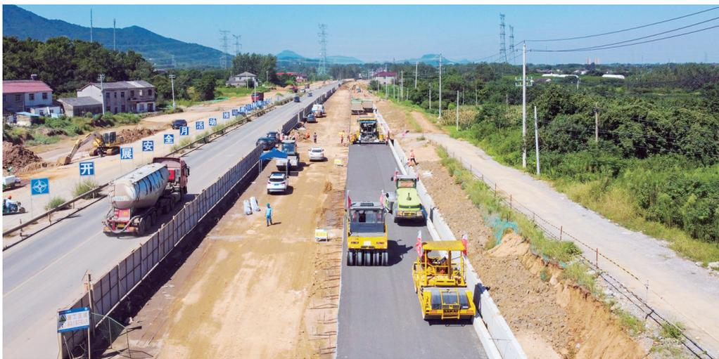
9月1日上午,312国道宁镇段快速化改造工程路面标开展MK14+180-MK14+660段右幅辅道冷再生底基层施工。截至目前,全线辅道单侧冷再生底基层已累计完成长度约9685米。
