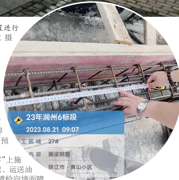
屋面圈梁钢筋验收中测量钢筋尺寸。 受访者供图
