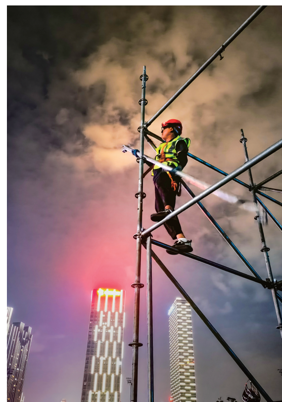
七月二十一日,辽宁大连市东港商务区音乐喷泉广场,施工人员连夜开展项目施工,完善旅游项目建设。 大连 张芝军/摄(华为 P50 Pro)
