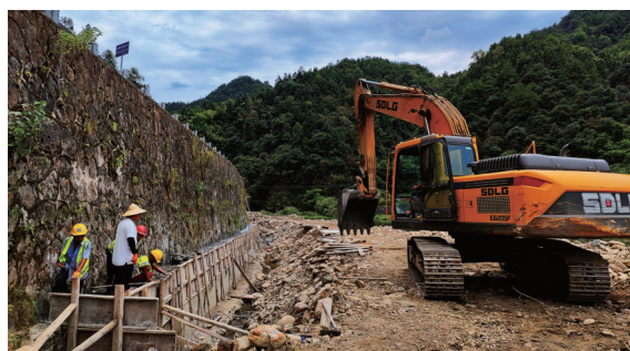
7月26日,浙江开化县油古线16K+480路段,工作人员冒着酷暑对受损的挡墙基础进行加固。 开化 徐曙光/摄(OnePlus 10 Pro)
