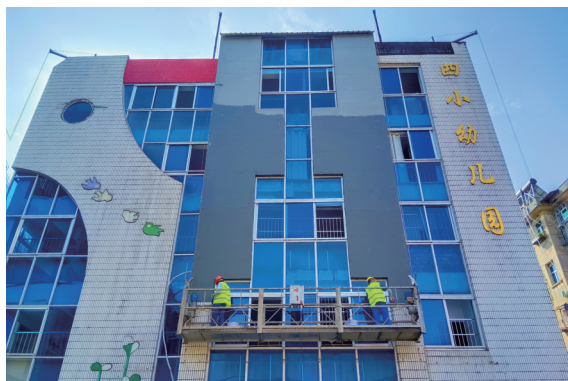
7月21日,安徽安庆市四照园小学幼儿园改造工地现场,工人师傅正保质保量按期完成工程任务。 安庆 黄安/摄(vivo Y76s)
