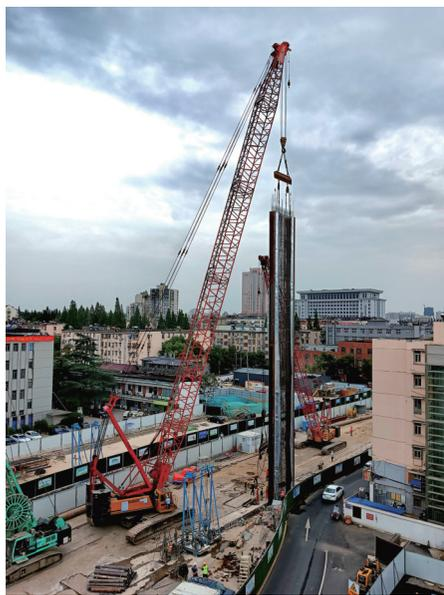
7月15日,江苏南京天气闷热,地铁6号线富贵山站施工现场,工人们将几十米高钢架结构地笼吊装下地。
