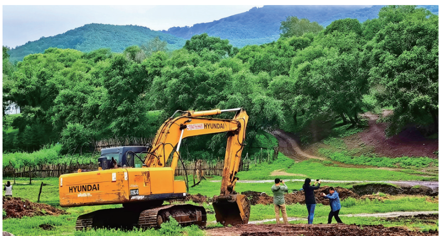
入夏之后,内蒙古大草原迎来了旅游旺季,在内蒙古自治区克什克腾旗乌兰布统桦木沟国家森林公园内,为不断完善基础设施,方便游客更好地体验大自然之美,景区加紧筑路修桥。
