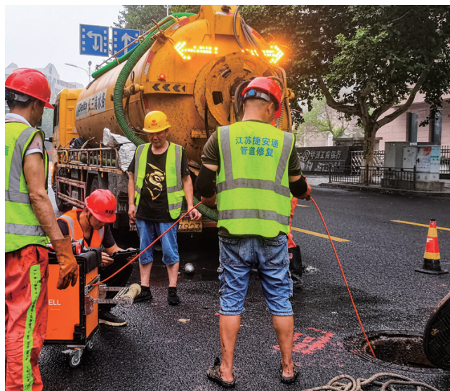
近日,江苏镇江大市口附近,工作人员使用先进设备对市区地下排水系统进行检测,防止因雨汛排水不畅而影响市民工作与生活。
