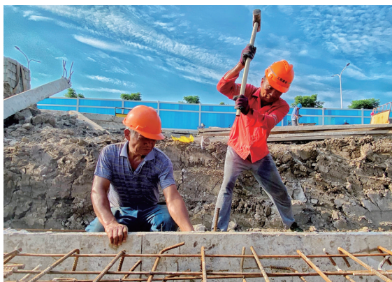
7月15日,上海浦东新区河北路施工现场,工人冒着酷暑,抓紧时间施工。
