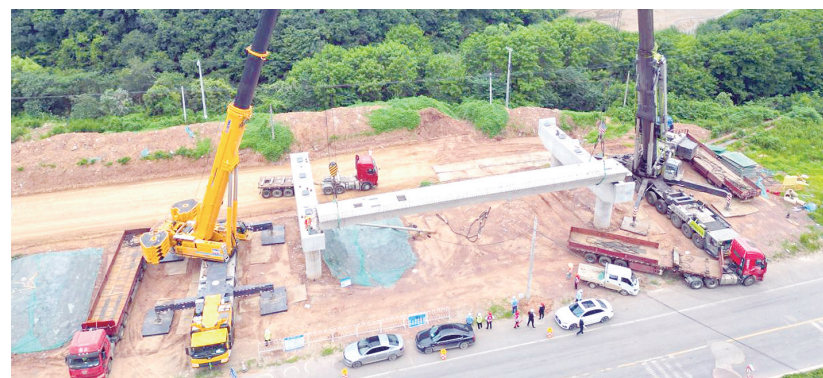
伴随着隆隆机械声,近日,312国道宁镇段快速化改造工程JR2标段MK28+527大桥首片30米预制箱梁被两台500吨汽车吊缓缓吊起,越过距地面7米高的盖梁,经精准定位后稳稳地落在支座上,标志着JR2标段桥梁正式进入上部结构施工阶段。 张杨 黄帅 摄影报道
