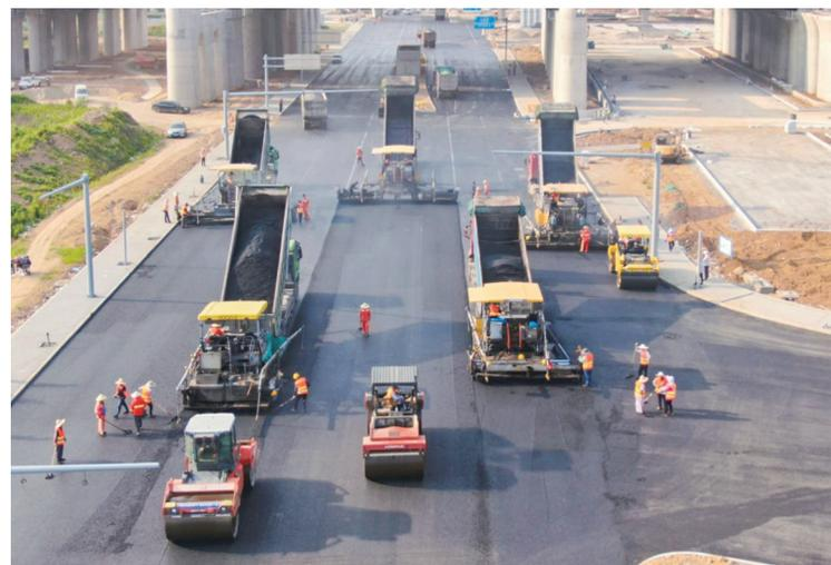
近日,句容市立体综合交通枢纽市政配套工程进入上面层沥青摊铺阶段,为实现与沪宁沿江高铁句容段同步投入使用奠定坚实基础。据了解,此次摊铺的路段是句容市立体综合交通枢纽市政道路配套工程的两条道路,分别为宁杭南路和勤学路。
