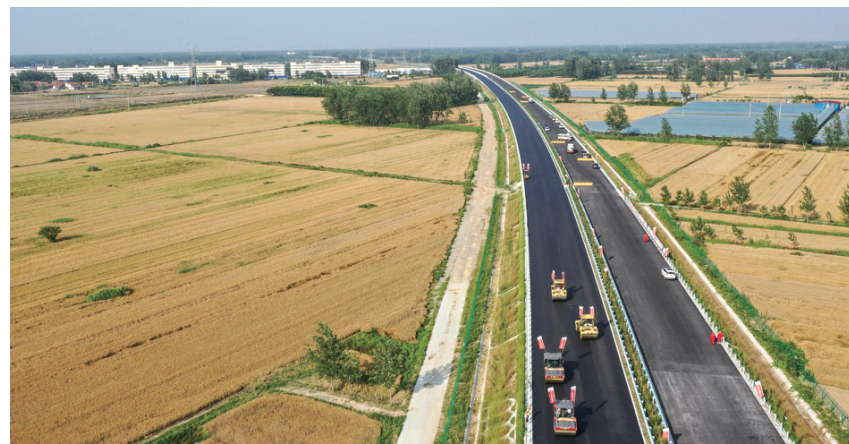
工人在连宿高速公路沭阳至宿豫段施工(6月6日摄，无人机照片)。近年来，江苏省有序推进多条新建高速公路建设，加速打通国家高速大动脉，畅通省级高速“毛细血管”。截至2022年底，江苏高速公路里程达到5087公里。
