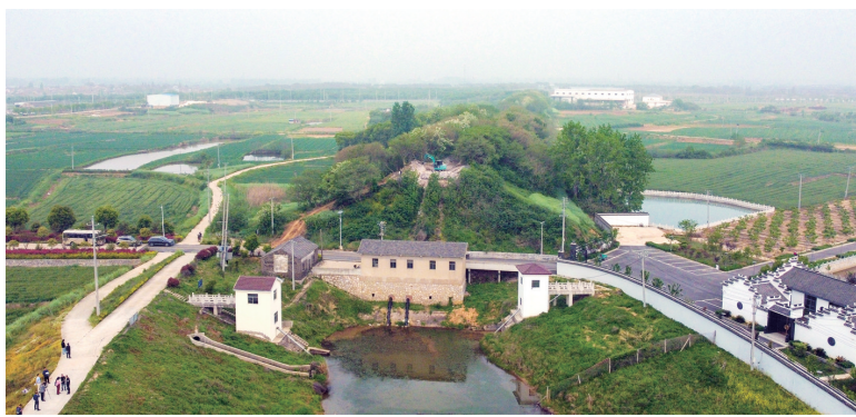
4月19日,记者在句容白兔镇、黄梅街道、茅山镇看到,水利部门在当地河道沿线翻新维护灌溉泵站、清理河道、提水补库,加大农田水利设施建设力度,提高农田灌溉效率。 黄帅 徐剑 陶凯 摄影报道
