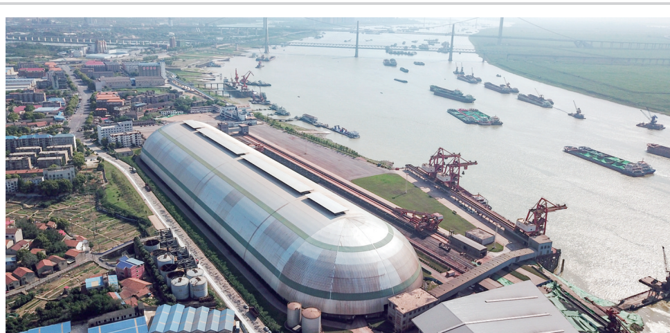
这是4月17日拍摄的湖南省岳阳市城陵矶港“胶囊”形散货大棚(无人机照片)。近期,位于洞庭湖与长江交汇处的湖南岳阳城陵矶港货船穿梭,一派繁忙。城陵矶港环保提质改造项目主体工程——全封闭“胶囊”形散货大棚2020年投入使用后,有效解决城陵矶港的货场粉尘污染问题,有利于保护长江生态环境。 新华社发
