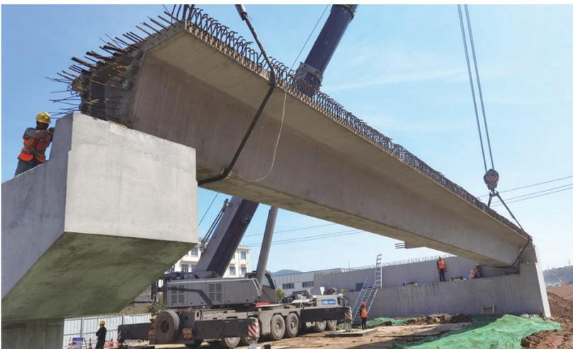
近日,312国道宁镇段工程经远路大桥首片箱梁架设完成,拉开了经远路大桥上部结构施工的序幕。经远路大桥位于312国道宁镇段工程JR3标段,全长452.9米,共4联,单跨10片箱梁,总计140片箱梁。朱浩 刁益彤 摄影报道
