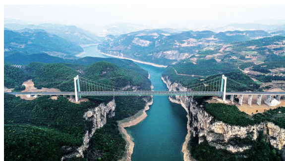
这是4月12日拍摄的金峰乌江大桥(无人机照片)。日前，由贵州路桥集团承建的贵金古(贵阳经金沙至古蔺)高速金峰乌江大桥项目主桥建设已完工，开始为通车前的荷载试验做准备。 新华社发
