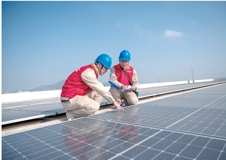
1月12日，我市一座30兆瓦屋顶分布式光伏电站顺利并网投运。
