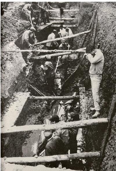
1984年,中山路拓宽工程大市口段施工沟内,发现唐代木构下水道遗迹。
