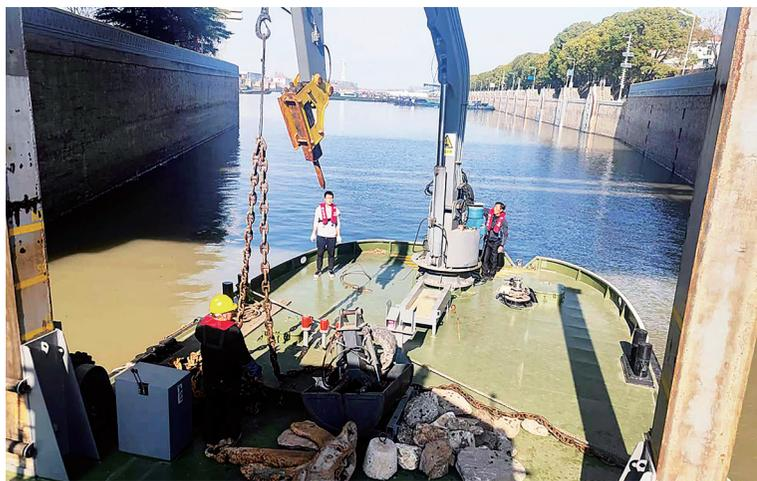
近日,谏壁船闸二线闸两侧闸门出现闸门无法关闭到位的情况,在利用港航多功能船多波束设备对二线闸进行了全面扫测后,经潜水员与多功能船配合,及时清除了二线闸闸门区域的水下障碍物,使闸门开关恢复正常。
