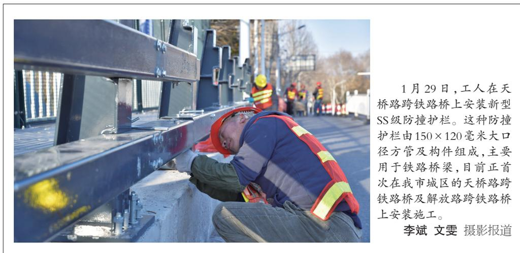
1月29日,工人在天桥路跨铁路桥上安装新型SS级防撞护栏。这种防撞护栏由150×120毫米大口径方管及构件组成,主要用于铁路桥梁,目前正首次在我市城区的天桥路跨铁路桥及解放路跨铁路桥上安装施工。
