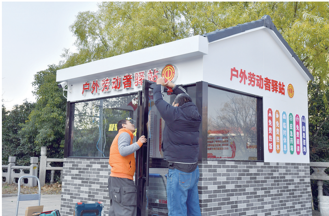
1月3日,市区运河路南水桥旁工人正在建设一座“智能化户外劳动者驿站”。这是我市首座主要服务“马路零工族”等户外劳动者的“驿站”,将全天24小时提供开水、微波炉热饭、急救药品、用工信息等服务。 李斌 范翊 摄影报道
