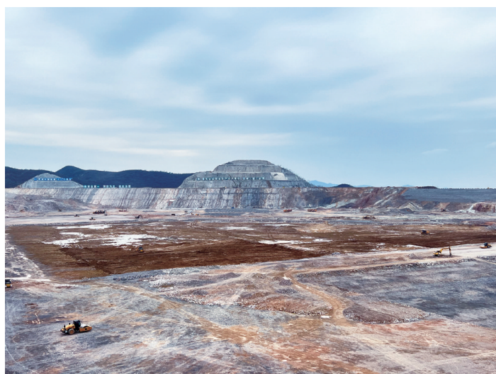
连日来,江苏句容抽水蓄能电站工程项目现场一派热火朝天的景象,工程正在有条不紊、紧锣密鼓地推进之中。
