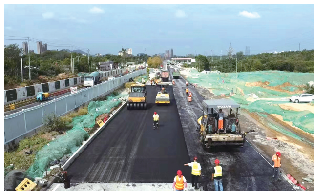
9月25日,346国道镇江城区段快速化改造工程一标段开始底层和中层沥青摊铺工作。此次沥青摊铺为箱涵施工导改段(架鼓山路-环山路)约300米。 文雯 杜广晨 摄影报道
