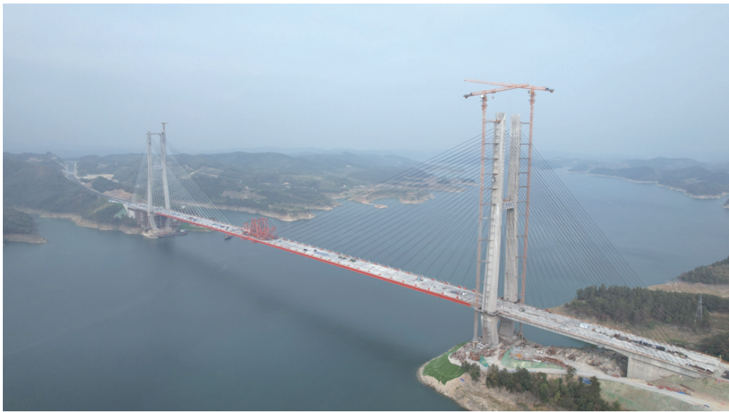
十浙高速丹江口水库特大桥。央广网发(中交二航局供图)
