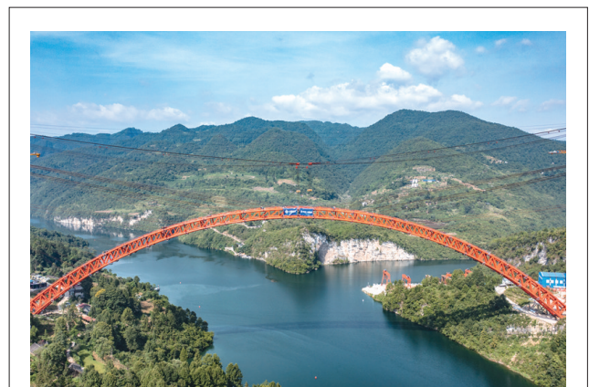
8月15日,由中交一公局承建的德余高速乌江特大桥顺利合龙。德余高速乌江特大桥位于贵州省思南、石阡、凤冈三县交界处,是德江至余庆高速公路的重要控制性工程,大桥全长1834米,主桥为504米上承式钢管混凝土拱桥。图为德余高速乌江特大桥合龙现场。 新华社发
