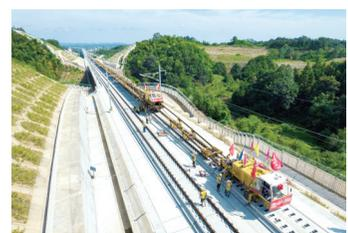
7月23日,在常(德)益(阳)长(沙)铁路常益段铺轨现场,随着中铁十一局施工人员将最后一对钢轨铺设在线路左线的无砟轨道板上,常益长铁路全线轨道贯通。据了解,常益长铁路线路全长约157公里,设计时速350公里,是国家“八纵八横”高速铁路网的重要组成部分,建成后 will 实现湖南全省14个市州全部通高铁的目标。
