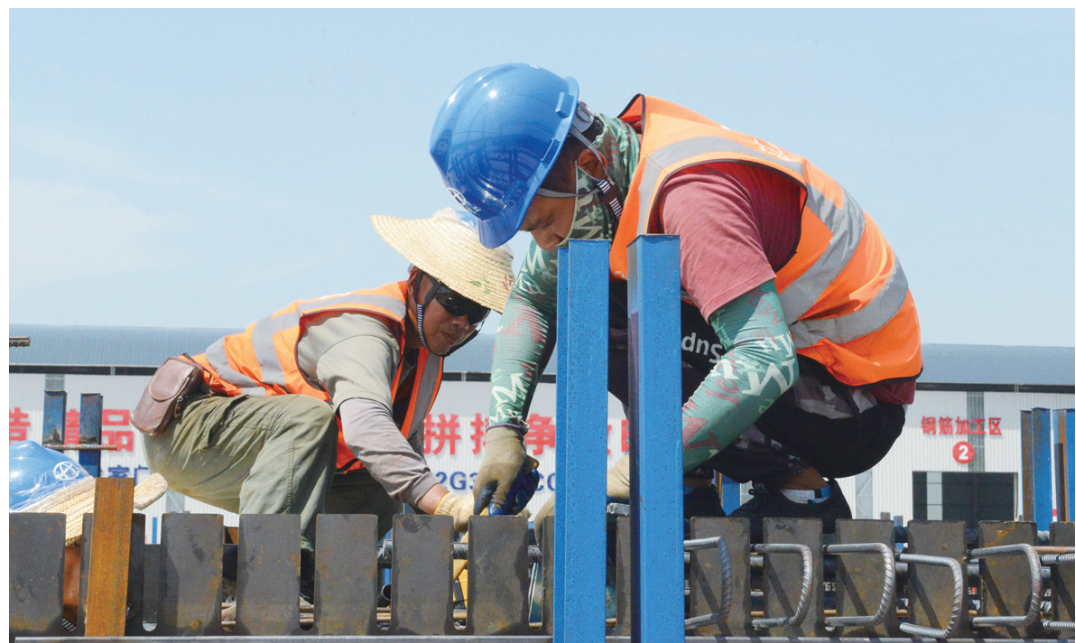
7月13日，312国道宁镇段快速化改造工程G312G346-CQ3标预制梁场建设现场，工人们正默契配合，铆足劲儿，娴熟地绑扎顶板钢筋，安装封头模板。 黄帅 陆晓霖 摄
