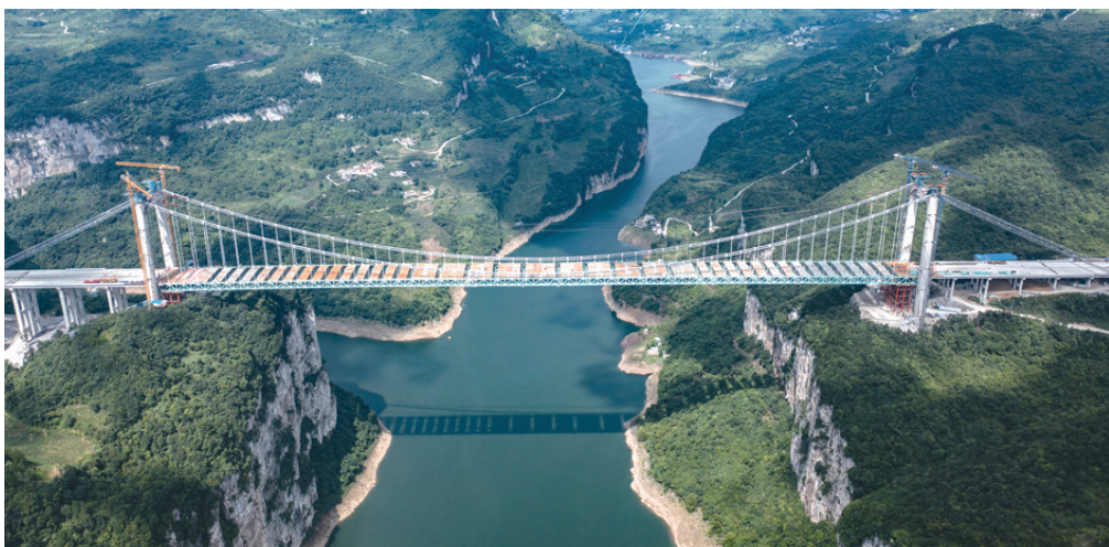
7月10日拍摄的金峰乌江大桥合龙现场(无人机照片)。当日上午,随着最后一块钢桁梁吊装到位,由贵州路桥集团承建的金峰乌江大桥顺利合龙。金峰乌江大桥是贵阳经金沙至古蔺(贵金古)高速公路项目的重要控制性工程,全长1473.5米,大桥的合龙为贵金古高速公路明年通车打下坚实基础。 新华社发
