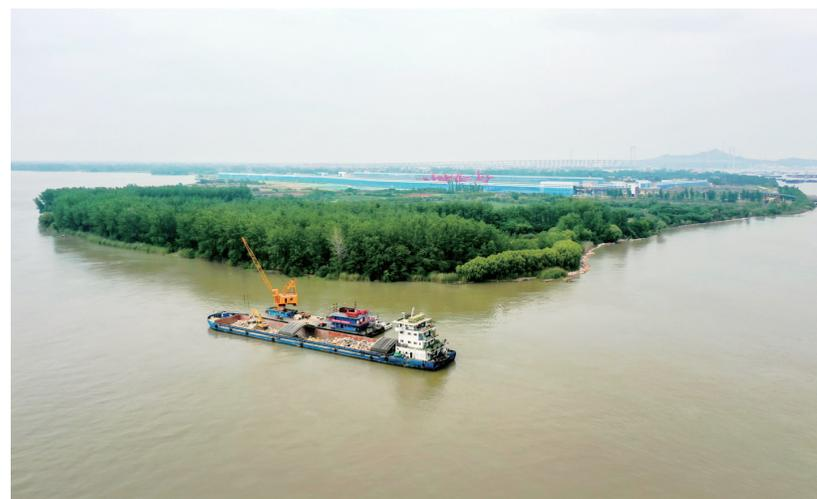
7月8日,在丹徒区高桥镇孟家港下段,运输船正开展护岸工程抛石作业。该应急护岸工程为2022年我市民生实事项目之一,将加固护岸1884米,抛石16.92万立方米。目前现场施工已基本完成。
