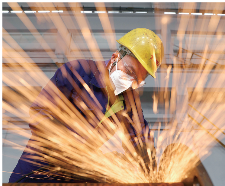
昨天，在湖南省衡阳市，特变电工衡阳变压器有限公司工人进行打磨作业。近日，各地企业统筹做好疫情常态化防控和生产经营，进一步稳工稳产。
