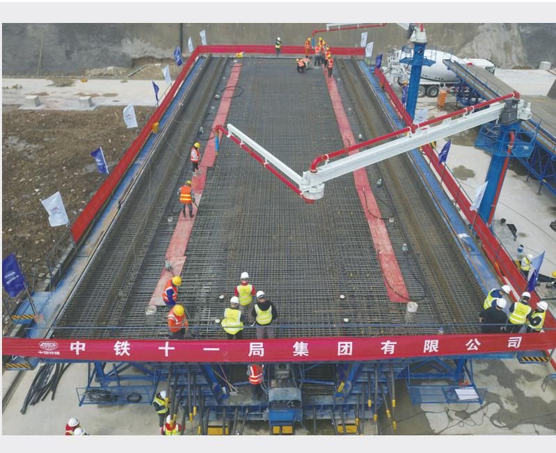
昨日，在中铁十一局沪渝蓉高铁武宜段钟祥制梁场，沪渝蓉高铁武宜段全线首榀箱梁开始浇筑，标志着沪渝蓉高铁正式进入箱梁预制生产阶段。钟祥制梁场位于湖北省荆门市钟祥市，主要承担沪渝蓉高铁556榀简支箱梁的预制任务。沪渝蓉高速铁路是我国“八纵八横”高速铁路网中“沿江通道”的主线部分，设计时速350公里。 新华社发
