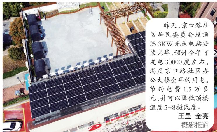
昨天,京口路社区居民委员会屋顶25.3KW光伏电站安装完毕,预计全年可发电30000度左右,满足京口路社区办公大楼全年的用电,节约电费1.5万多元,并可以降低顶层温度5-8摄氏度。
